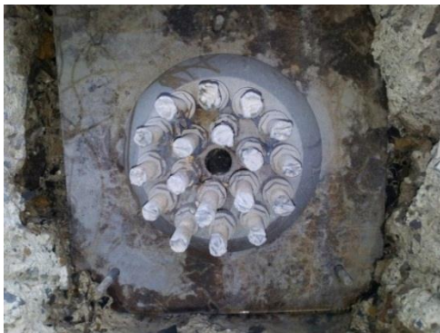
Bild 3: Freigelegter Spannkopf [1]
