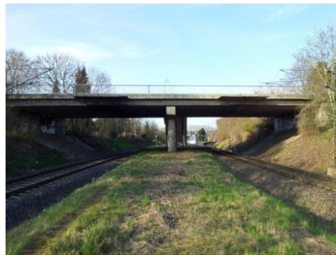
Bild 4: Ansicht des Brückenbauwerks [1]
