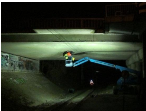
Bild 1: Arbeit in nächtlichen Sperrpausen [1]
