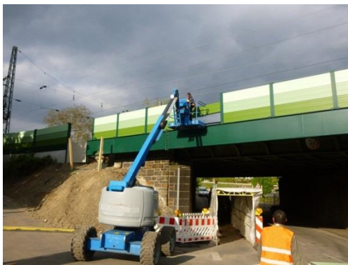
Bild 3: Einbau der Schallschutzelemente [1]
