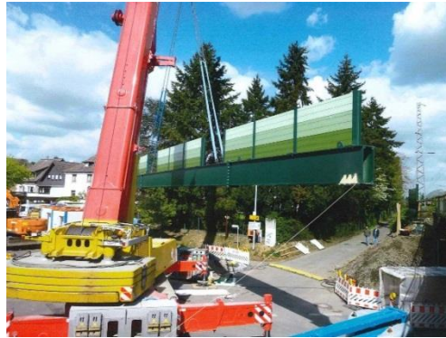
Bild 2: Einheben des Torsionsbalkens [1]
