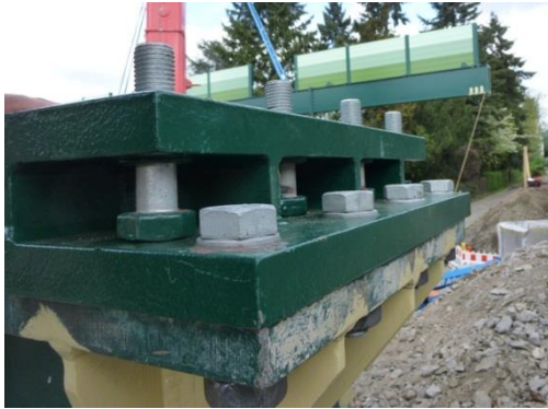
Bild 1: Stahldistanzstück und Verstärkung [1]
