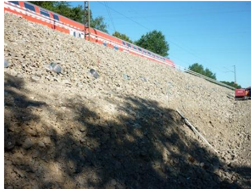
Bild 2: Bahndamm im Bauzustand [1]
