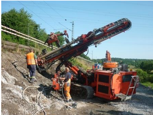
Bild 1: Herstellung der Verpresspfähle [1]
